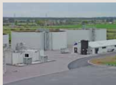
Производственный объект в Байе, очистные сооружения
