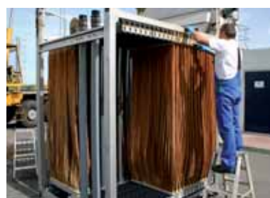
Монтаж ультрафильтрационных мембран в Гольца (Польша)
